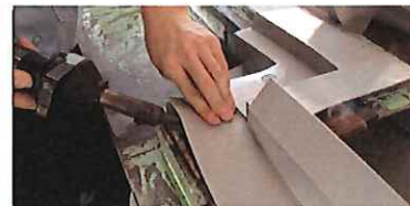
組付作業風景③ 樹脂ライスター
