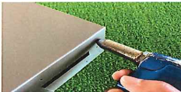
組付作業風景② ビス止め
