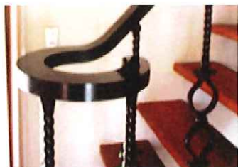
階段・手すり2
