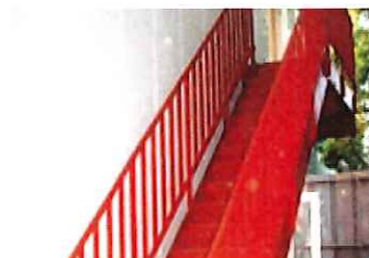
階段・手すり1
